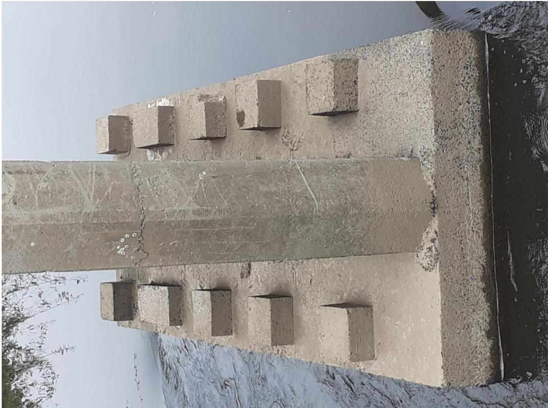
Ponte Cerro Baio em Rio Rufino, se necessária ancoragem do bloco rocha para a água corrente não prejudicar a estrutura da ponte (vista da cabeça dos tirantes ancoragem blocos fundação etc.).
