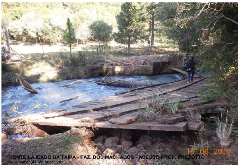
**Fotografia 01: Ilustra a estrutura (tabuleiro) deslocado e o pilar central tombado.**
